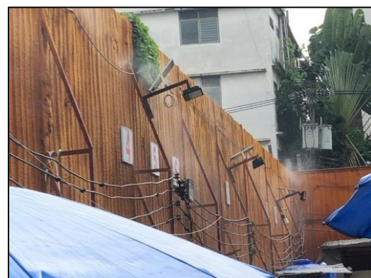
ภาพที่ 10 ติดตั้งสเปรย์น้ำบริเวณผ้าใบ Mesh Sheet และรั้ว
