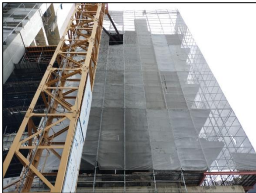
ภาพที่ 8 ผ้าใบกันฝุ่น (Mesh Sheet)
