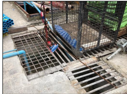
ภาพที่ 23 บ่อคัดตะกอน และตะแกรงดักขยะ
